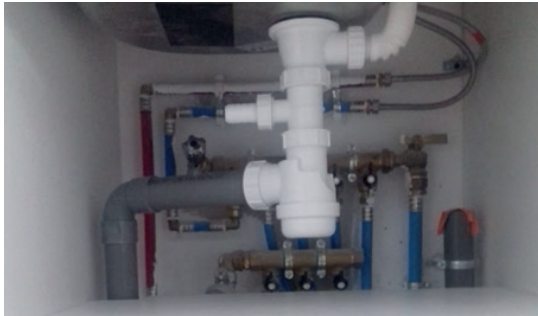
Logements collectifs 2B Nord - Euromed Marseille (13)
