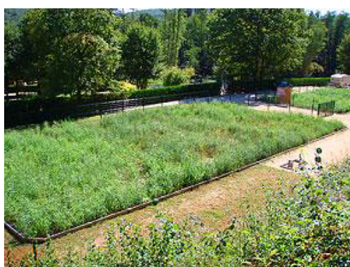
Filtre planté de roseaux en phase d'alimentation
